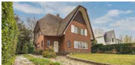
PARK VAN SCHOTEN | TE RENOVEREN VILLA
